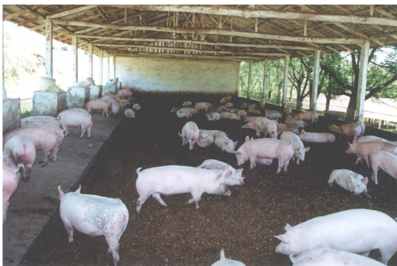
Figura 3 — Vista da edificação para a criação de suínos sobre leito formado por maravalha (Granja Fontana Gaurama/RS).
